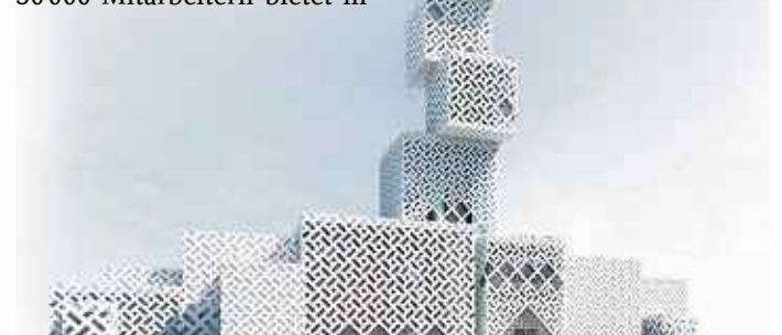
Im chinesischen Foshan Cube Tower baut ThyssenKrupp Elevator insgesamt 34 Aufzüge ein. Foto: TKE
